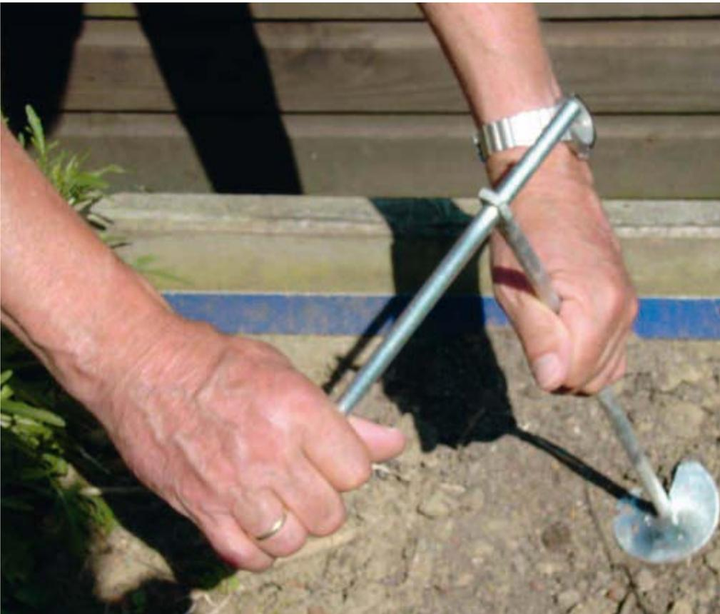
Eindreihen des ASS Erdankers mittels der Eindreihhilfe
